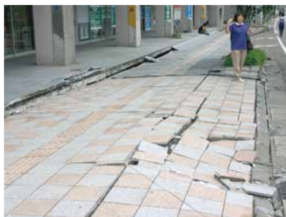
地盤沈下した本店前の通り 写真提供: 越後タイムス社
