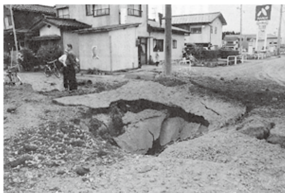
路面が大きく陥没した市内半田2の道路。周囲も波打つ状態となった16日
