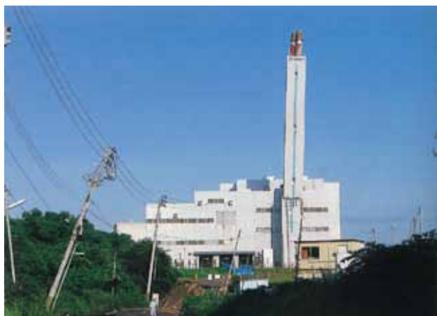
傾いた煙突 写真提供: 越後タイムス社
