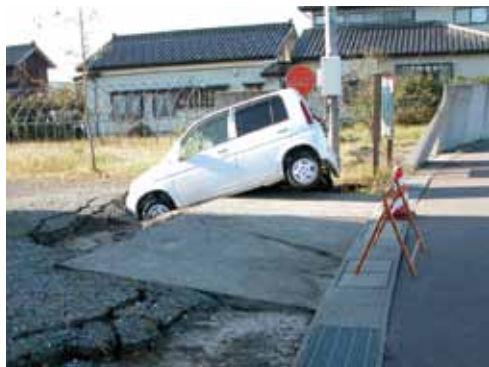
液状化で陥没した穴に落ちた車(刈羽村)
