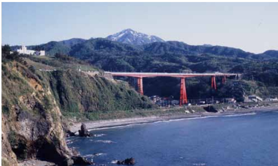
米山と米山大橋
